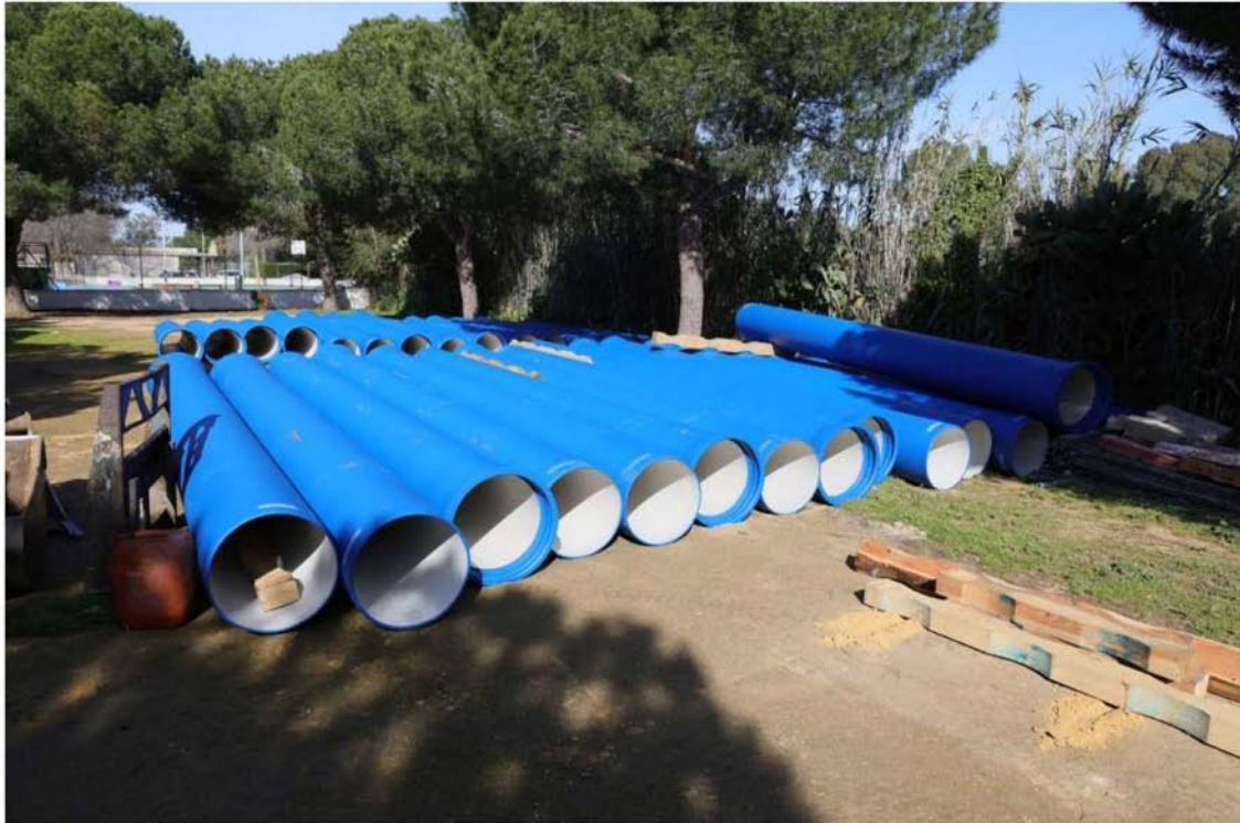
La red de saneamiento se sustituirá en este punto
