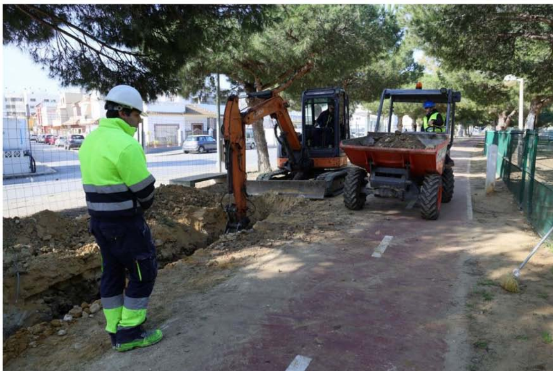
Las obras durarán unas 12 semanas
