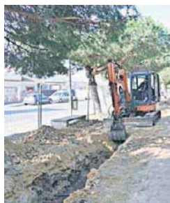
Renovación de tuberías en Carlos Cano.
