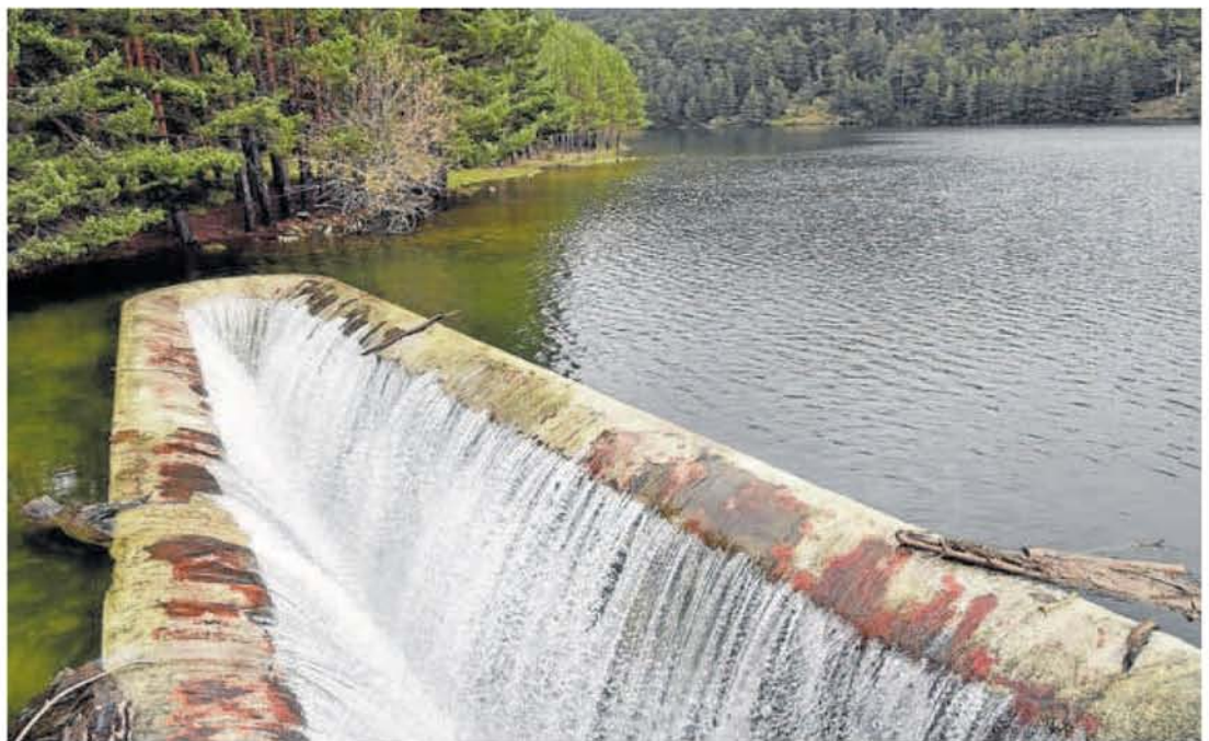
Parte de la infraestructura de la presa en el embalse de El Tejo, en El Espinar. PEDRO LUIS MERINO
